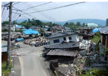
熊本地震で被災した建物(益城町)
